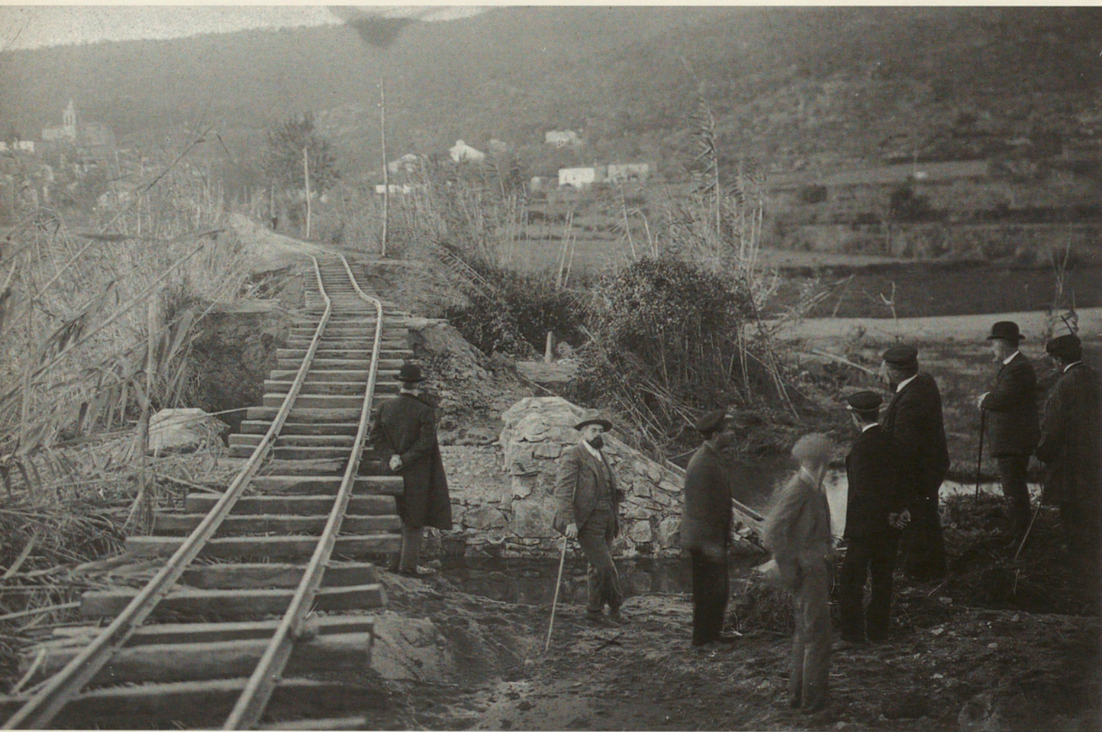
Pont del tren sobre el Ridaura després d'una riuada, 1908 Autor desconegut. Col·lecció Yolanda Albertí (reg. 670)
