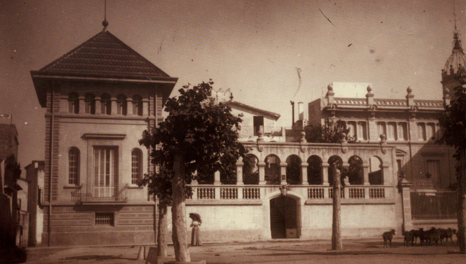
Casal de les germanes Llagustera i Surís edificat entre 1889 i 1890 al passeig del Mar.
