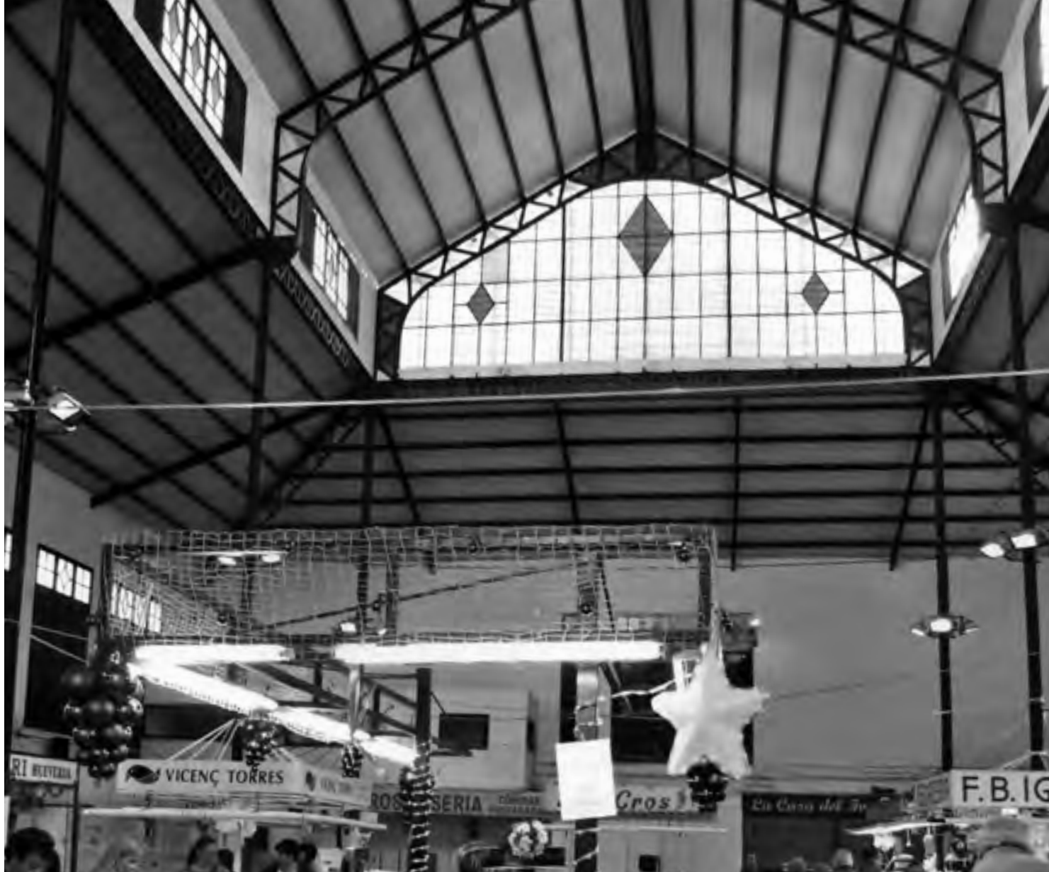
Vista de l'interior del mercat municipal, al gener del 2007. AMSFG. Fons Albert Gironès. (Autor: Albert Gironès)
