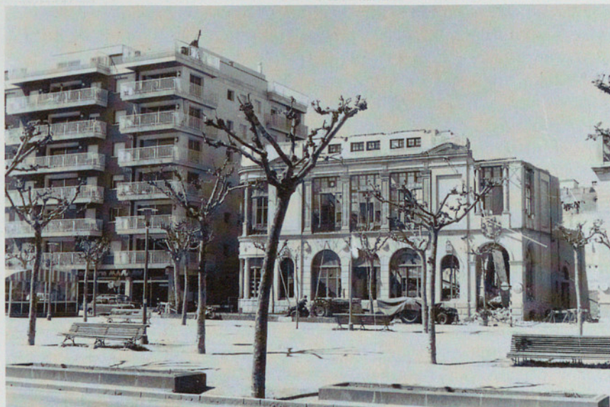
Casino «dels Senyors»-cinema Catalunya realitzada pel mes d'abril del 1976, en plena tasca de desballestament del singular edifici (AHMSFG).
