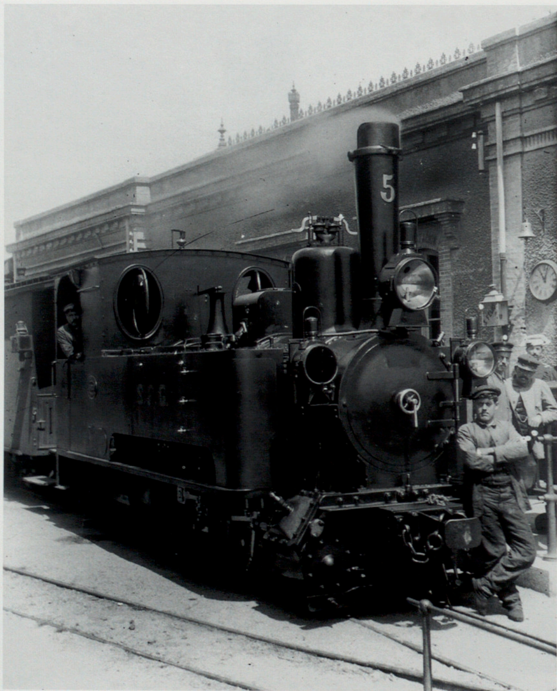
5 - Detall de la màquina 5 a l'estació de Sant Feliu.
