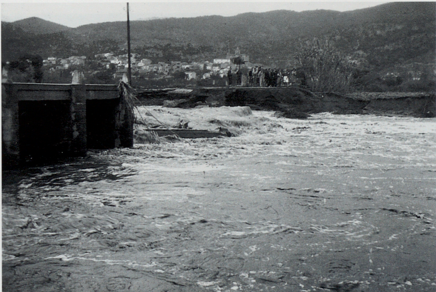
6 - Ensorrament del pont sobre el Ridaura per causa de l'avinguda del riu el 27 d'octubre de 1946.
