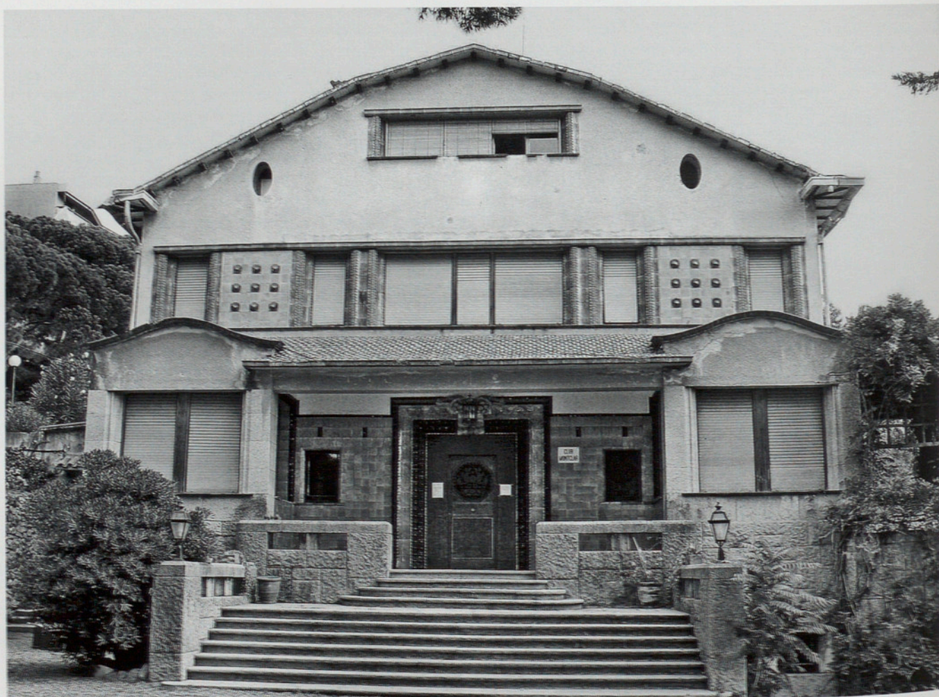
Xalet Casas, façana principal.
