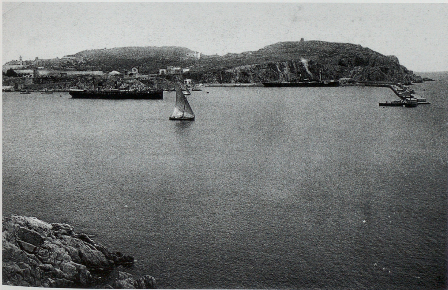
Treballs de construcció del port (1910-1912).
